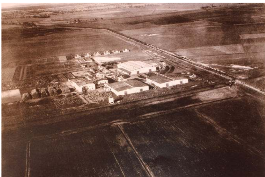
Große Hallen zum Lagern des geernteten Hanfstrohs prägen die 1918 in Betrieb genommenen Hanfröste in Bergerdamm. Erst wenige Wohnhäuser waren gebaut. Foto: Sammlung Torsten Strebel (Bergerdamm)
