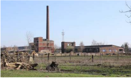
1936 ging in Fehrbellin eine Hanfröste in Betrieb. Eine Halle (rechts) und das Kesselhaus stammen aus der Zeit. Das Schäbenplattenwerk (links) wurde dagegen 1959 errichtet. Foto: Sven Bardua
