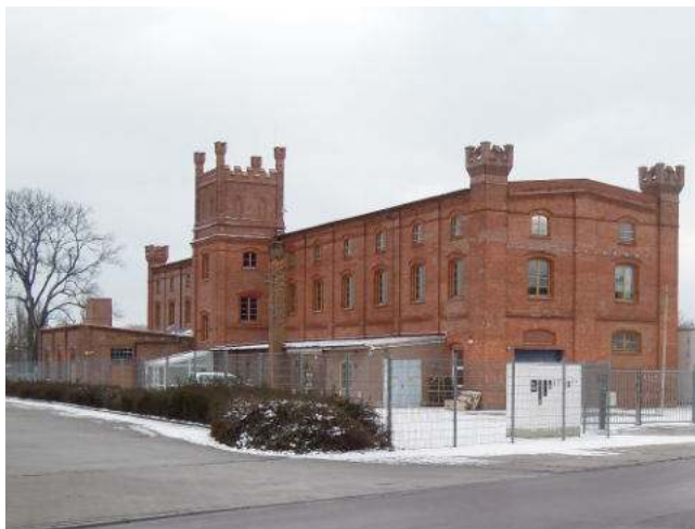
Die Bauhütter KG betrieb seit 1936 an der Geschwister-Scholl-Straße in Genthin eine Hanfspinnerei. Der Bau hatte zuvor der Paul Stolte AG als Betonwerk gedient. Foto: Alexander Calvelli
